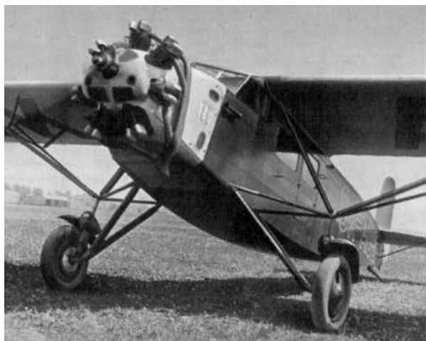
Letoun Aero A-35 Čs. státních aerolinií. Velmi dobrý stroj pro 5 cestujících, jímž byl obstaráván provoz na mnoha tratích v Československu. Motor 240 k.s.
