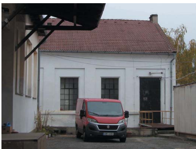
Pohled na původní dílnu fy AERO z nepřístupné strany
