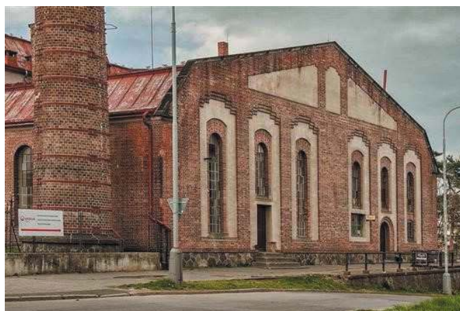
Průčelí čistírny odpadních hmot
